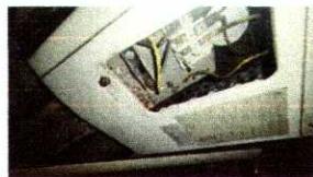
ar condensador (2).jpg
