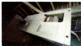
ar condensador (6).jpg
