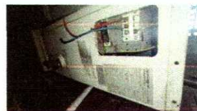
ar condensador (4).jpg
